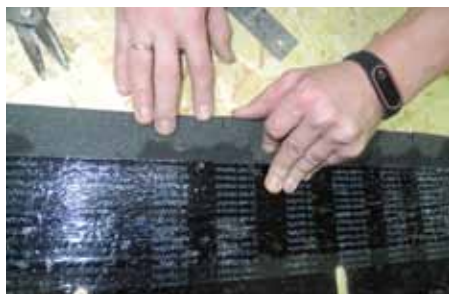
Рис. 5. Насечка для облегчения монтажа
