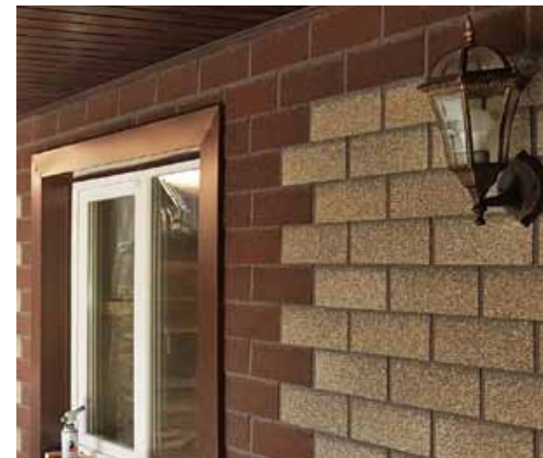
Рис. 3. Оформление оконных проемов
