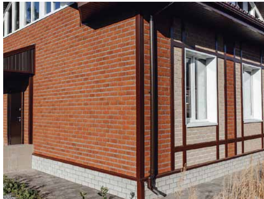
Рис. 1. Оформление фасада и цоколя
